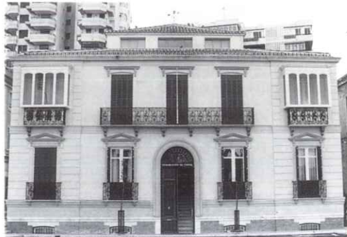
Nueva sede de la Demarcación de Costas Paseo de la Farola Málaga
