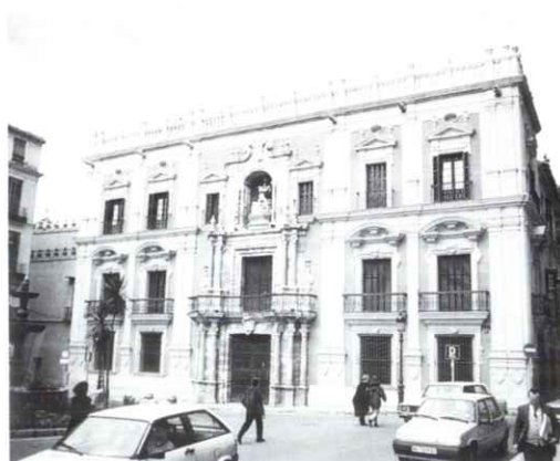
Restauración de la fachada del Palacio Episcopal Málaga
