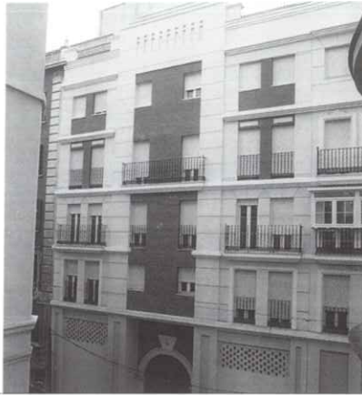
Edificio "Prysm" C/. Martínez Málaga
