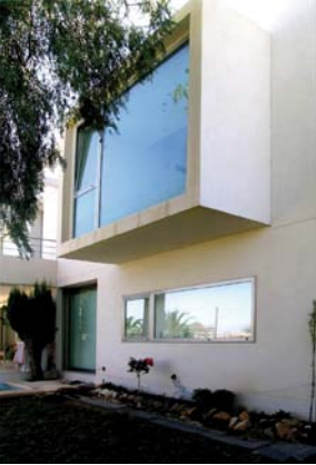
Ampliación y reforma de vivienda unifamiliar Urbanización El Pinillo Torremolinos
