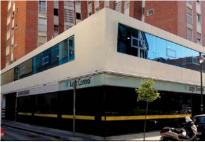
Reforma y adaptación puntual de oficina técnica Calle Maestranza Málaga
