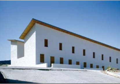
26 viviendas de protección oficial Alameda
