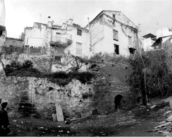
Estado anterior a la intervención
