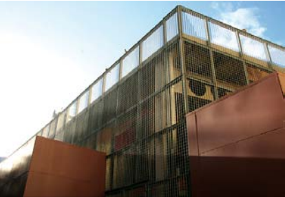
Primera fase de la rehabilitación del mercado provisional de Atarazanas Calle Camas Málaga
