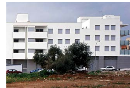
72 viviendas de protección oficial, locales, garajes y trasteros Santa Inés Málaga
